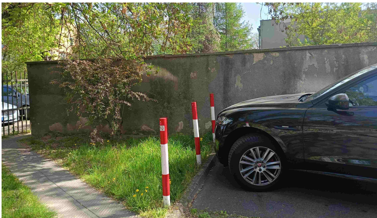
Fot. 1_Ogrodzenie murowane, uszkodzone tynki
